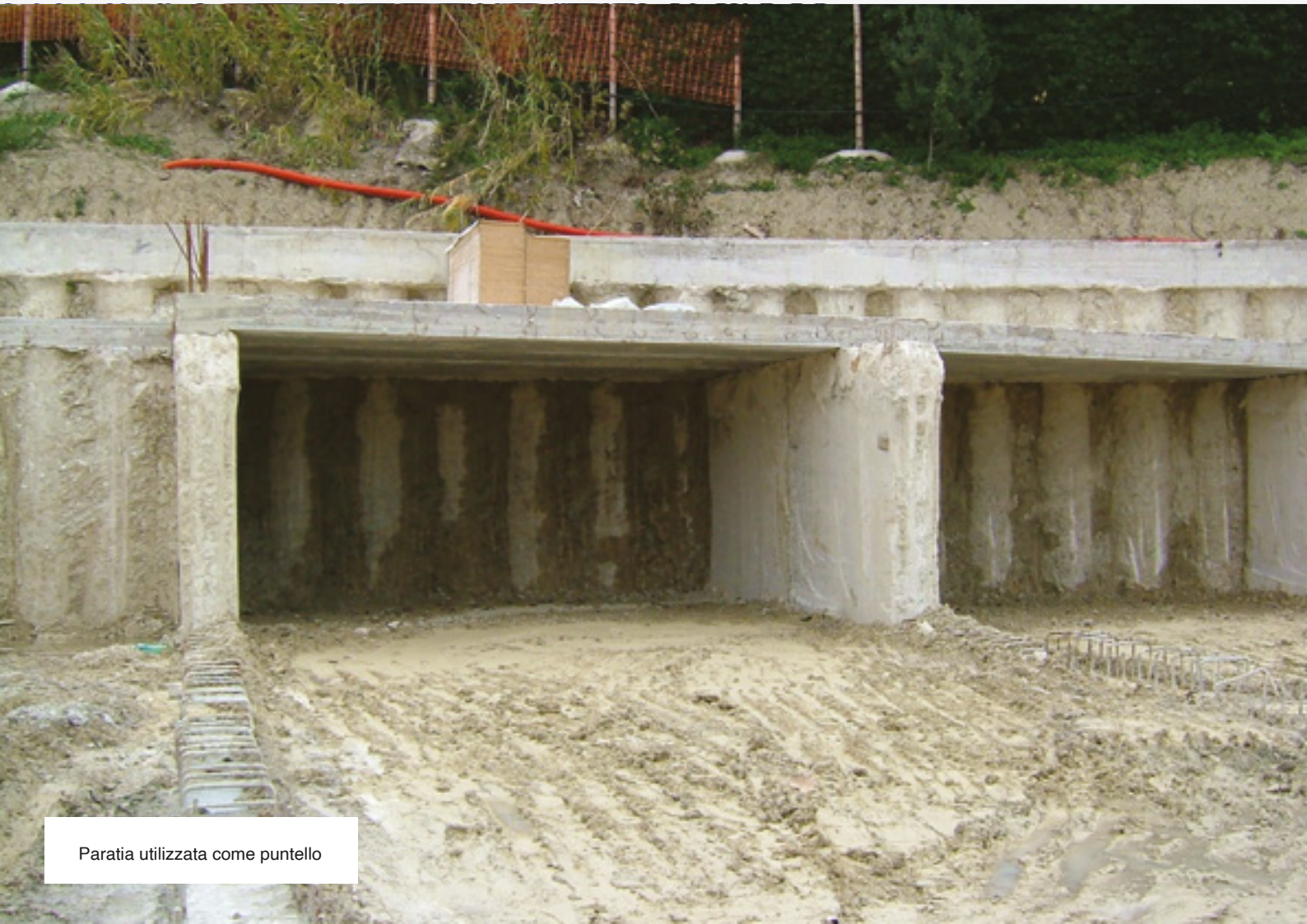
Puntellamento diaframmi con strutture metalliche
